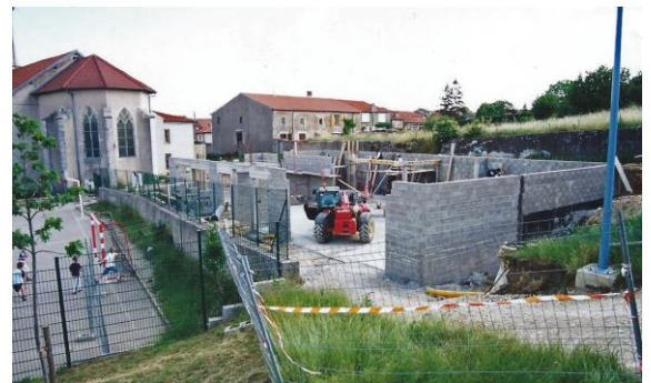
La nouvelle maternelle, en construction en 2004.
