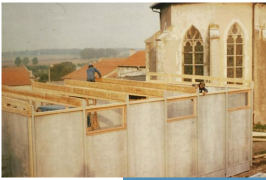
Le préfabriqué : bâti en 1979, en service jusqu' en 2000, démonté en 2002.
